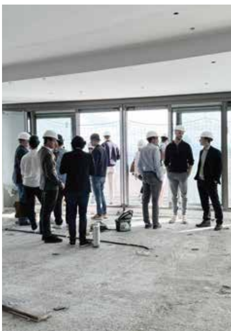
Circa 500 Wohnungen entstehen auf rund 50 Stockwerken.
